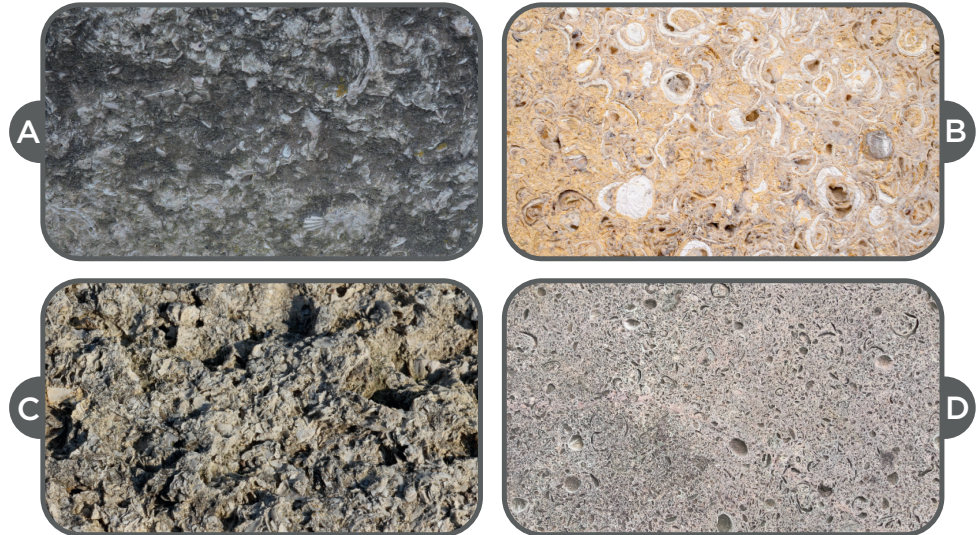
Réponse : Le calcaire coquillier de l'Écolothèque apparaît sur la photo A.
